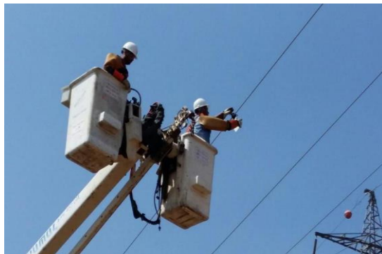
התקנת סמנים על קו מתח גבוה באמצעות במת הרמה, פיילוט עמק יזרעאל, חח"י.
